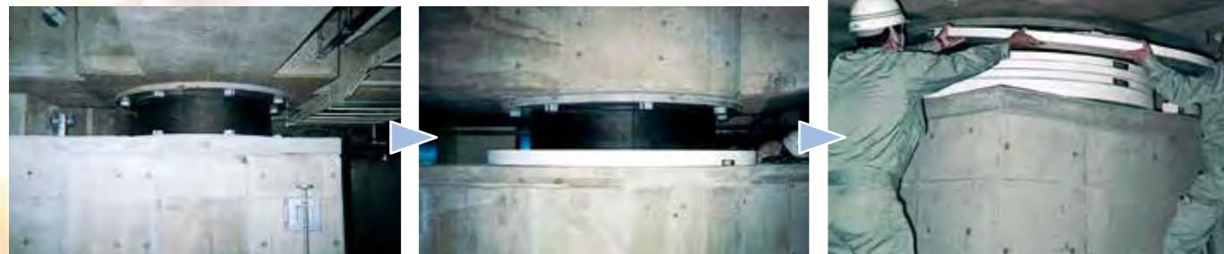
丸形積層ゴムの「護免火」耐火被覆工事(新築ビル)
